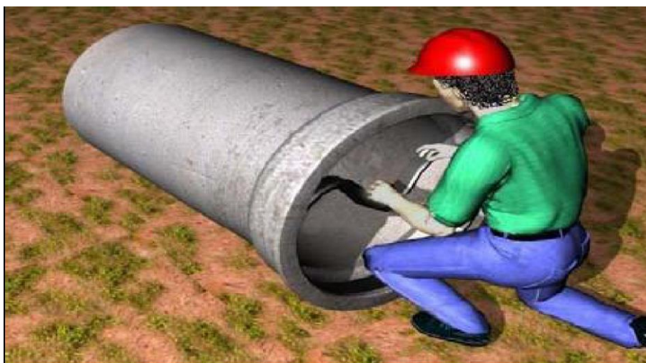
Figura 43 - Colocação do anel de borracha
